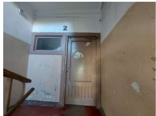
2.stāva kāpņu telpa
