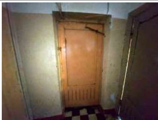
2.stāva kāpņu telpa
